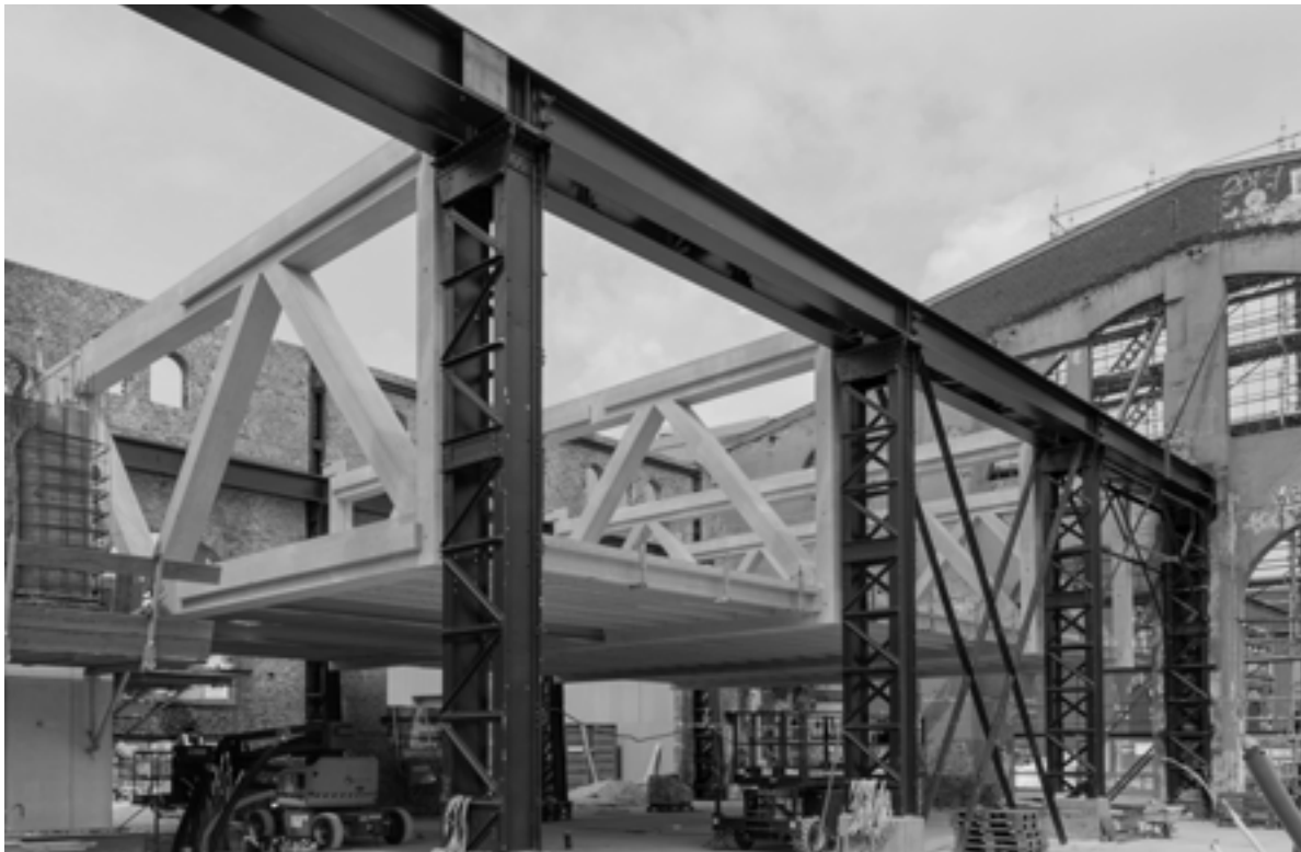
Transformation de Gjuteriet pendant le chantier. La nouvelle structure en bois étant rapidement assemblée sur place pendant l'été 2021.
