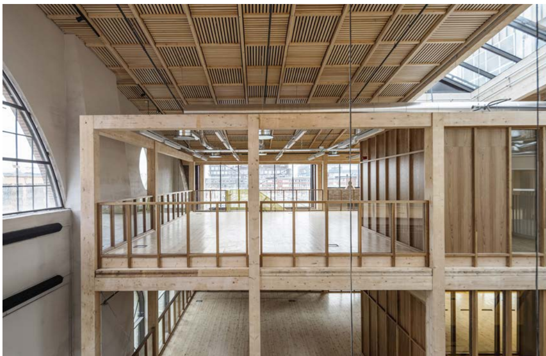
Den nya trästommen är frikopplad från ytterväggarna.
